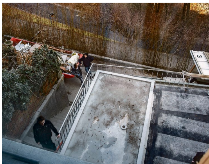
Der Warenlift hebt sich kaum von der Terrasse ab.
