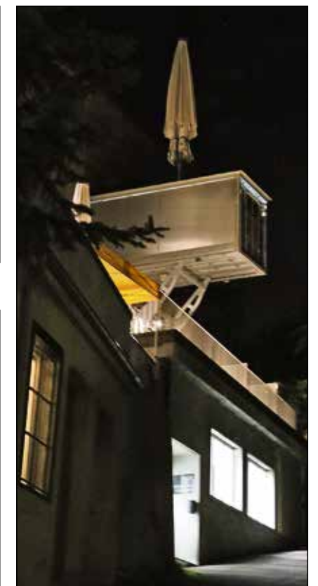
Aussenansicht des Warenlifts.
